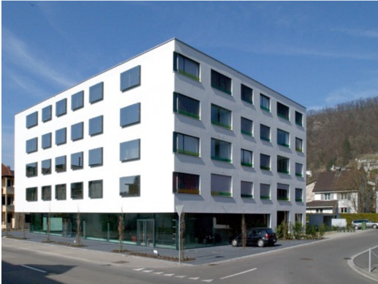
Wiesenstrasse - Aussenansicht Südwest
