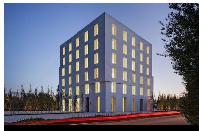
Bürogebäude 2226, Lustenau Baumschlager-Eberle Architekten
