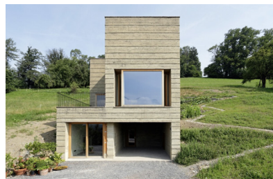
Haus Rauch, Foto B. Bühler, M. Rauch
